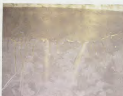
Abb. 6: Hot-Dog-Chilli-Bar-Prospekt in der Nahaufnahme: Verformte und abgelöste Polyesterläufer.
